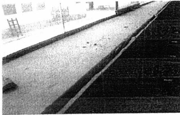
**FOTO N° 08.** Parte superior de los muros de las ventanas en donde el cerámico no ha tenido una correcta colocación, se ha dejado vacios entre la pared y la cerámica que han permitido que se cajoneen, lo cual se tiene que retirar y volver a colocar.
