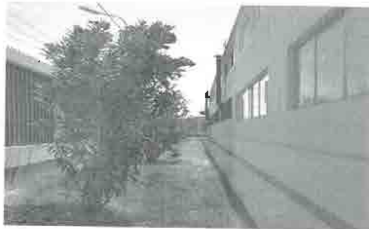
Zona de Ubicacion: Parte Lateral del Centro de Datos
