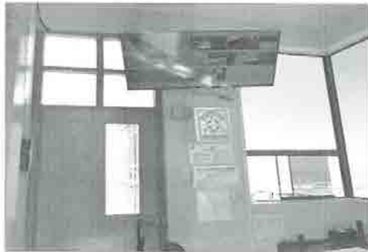
Caseta de Vigilancia
