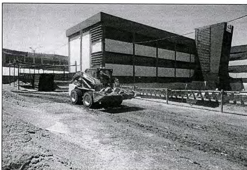
Construcción de Pabellón de Estudios Generales
