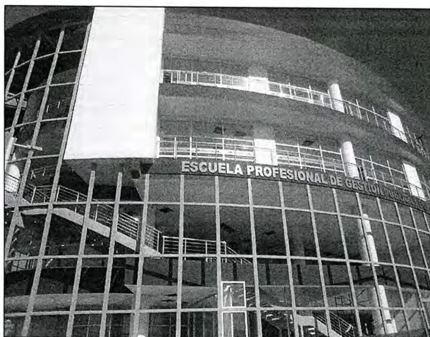
Construcción de la Escuela Profesional Gestión Pública
